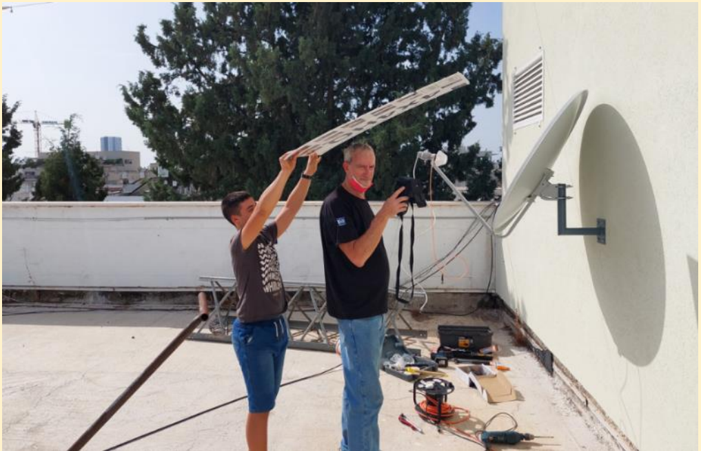
צביקה, 4Z1ZV מכייל את אנטנת הצלחת עבור תחנת הלויין הקטארי
